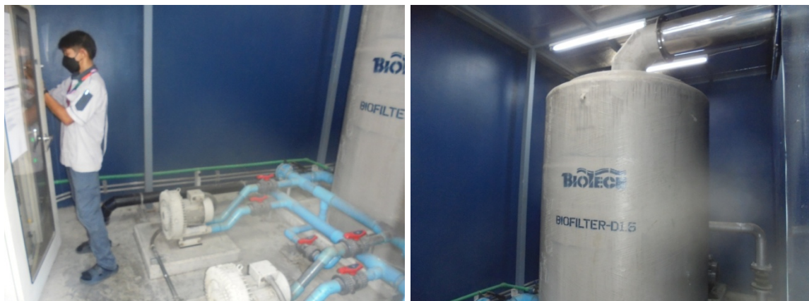
ภาพที่ 4-9 ดังกรงชีวภาพ Biofilter ในการบำบัดก๊าซมีเทนและแอมโมเนีย ปัจจุบันทำเป็นห้องเครื่องปั๊มระบบบำบัดน้ำเสียและดังกรงชีวภาพ
