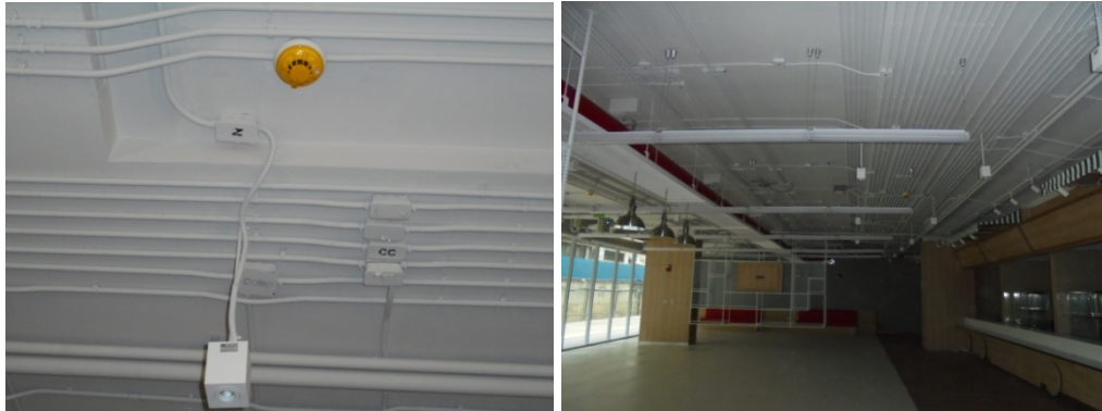
ภาพที่ 4-23 เครื่องตรวจจับควันและเครื่องตรวจจับความร้อนในห้องอาหาร
