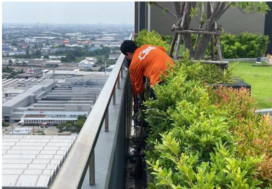
ภาพที่ 13 เจ้าหน้าที่ตรวจสอบท่อระบายน้ำ ดำเนินการขุดลอกดินตะกอนที่ตกค้าง
