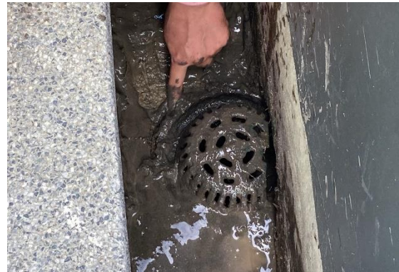
ภาพที่ 13 เจ้าหน้าที่ตรวจสอบท่อระบายน้ำ ดำเนินการขุดลอกดินตะกอนที่ตกค้าง
