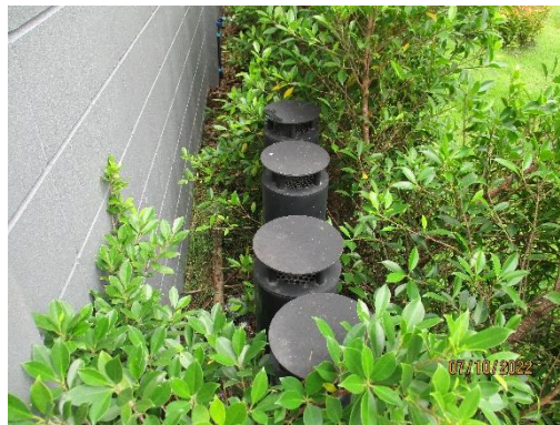
ภาพที่ 55 ระบบบำบัด Aerosol ด้วยวิธีผ่านกรอง (Filter)
