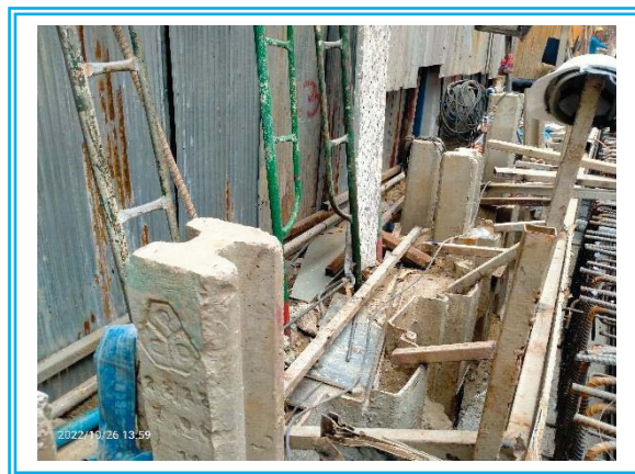
รูปที่ 3-33 ติดตั้ง Sheet Pile เพื่อป้องกันการ พังทลายของดิน
