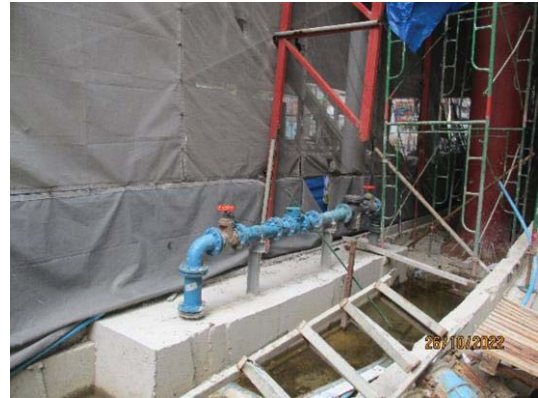
รูปที่ 3-16 เชื่อมต่อท่อประปาตามจุดที่ได้ขออนุญาตการเชื่อมต่อ
