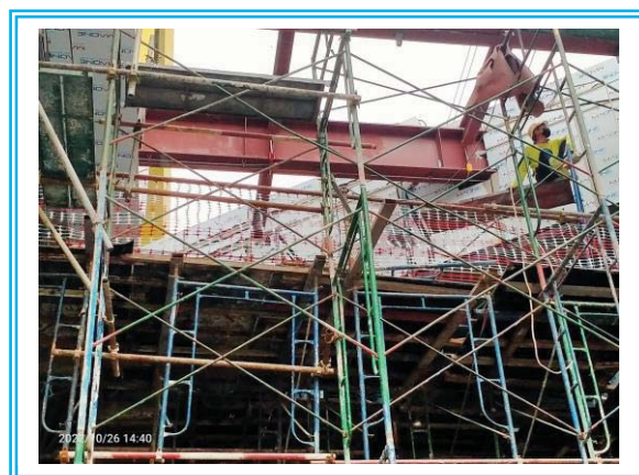
รูปที่ 3-40 นั่งร้านมีสิ่งป้องกันมิให้เป็นอันตรายต่อผู้ซึ่งทำงานอยู่ชั้นล่าง
