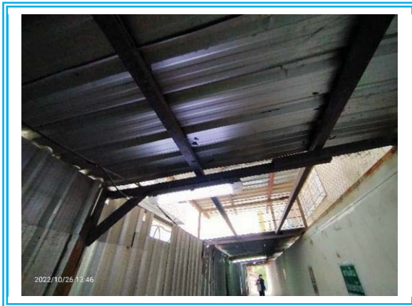
รูปที่ 3-2 แผ่นสังกะสีปกคลุมทางเดินเพื่อป้องกันวัสดุตกหล่น
