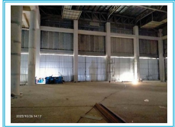
รูปที่ 3-6 ภาพถ่ายกันฝุ่นละอองและเศษวัสดุร่วงหล่น
