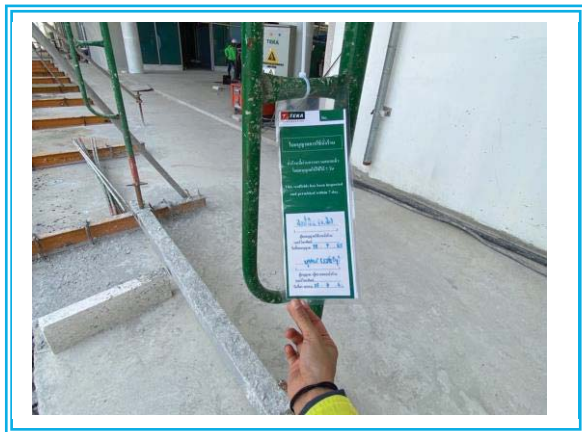
รูปที่ 3-39 ตรวจสอบนั่งร้านให้มีการใช้งานที่เป็นไปตามข้อกำหนด
