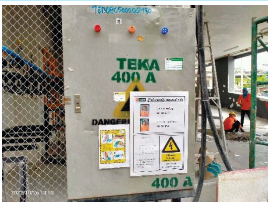
รูปที่ 3-35 สวิตช์ตัดวงจรไฟฟ้าเพื่อควบคุมการใช้ไฟฟ้า
