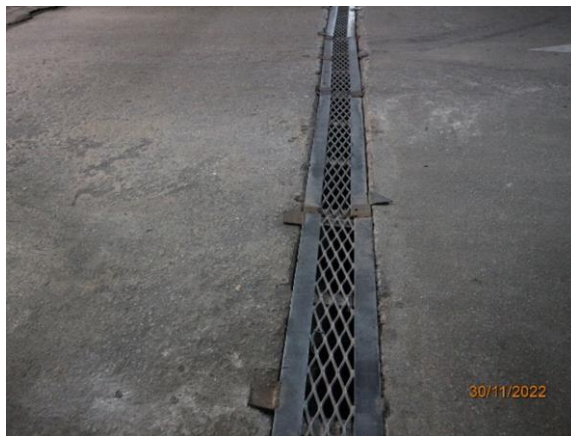
รูปที่ 3-15 รางระบายน้ำภายในโครงการ
