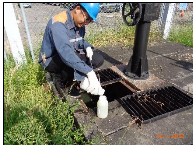
บ่อฟักสุดท้ายก่อนระบายน้ำทิ้งลงสู่รางระบายน้ำของโครงการอาคารเช่าเดิม
