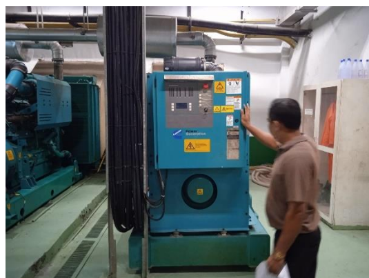
ภาพที่ 36 เครื่องกำเนิดไฟฟ้าสำรอง
