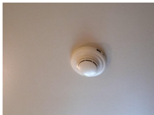
ภาพที่ 6 เครื่องตรวจจับควัน
