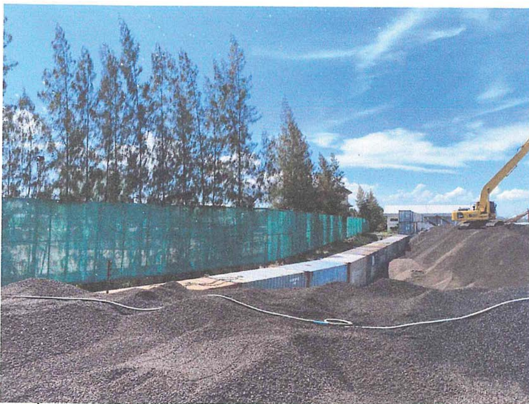
ภาพที่ 7 มีการชิงสแลนและปลุกต้นสนตลอดแนวเพื่อเป็นการดักจับฝุ่นละออง
