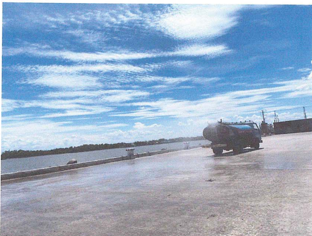
ภาพที่ 3 ใช้รถน้ำปล่อยสเปรย์น้ำลงบนพื้นถนนบริเวณท่าเทียบเรือเพื่อลดการฟุ้งกระจายของฝุ่นละออง ทุก 1-2 ชั่วโมง/ครั้ง
