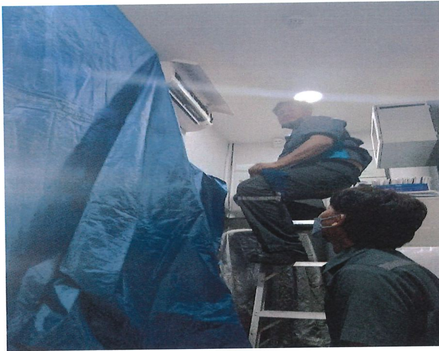
ภาพที่ 1.34 ภาพการล้างเครื่องปรับอากาศ
