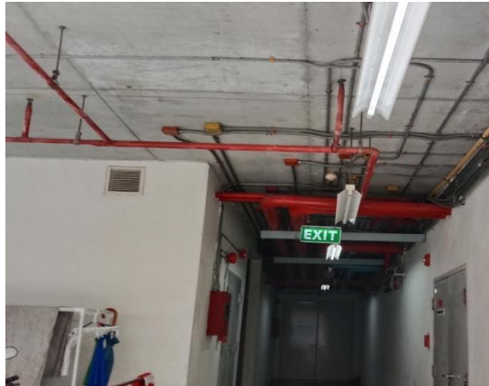
- ระบบดับเพลิงแบบกระจายน้ำอัตโนมัติ
