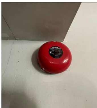
กริ่งเตือนเพลิงไหม้
