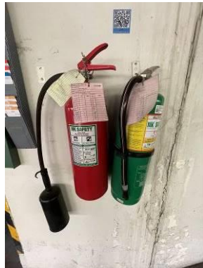
ถังดับเพลิง CO 2 และถัง ดับเพลิง Clean Agent
