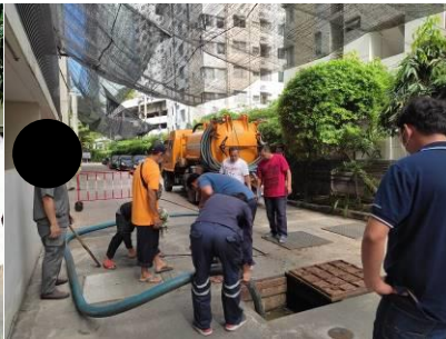
รูปที่ 2-16 สืบล้างสิ่งปฏิกูลบ่อบำบัดบ่อเกรอะและบ่อไขมันอาคาร A, B เมื่อวันที่ 8 ธันวาคม 2565
