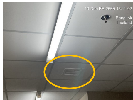
ภาพที่ 2.2-26 พัดลมดูดอากาศในห้องพัสดุฝอยเปียก
