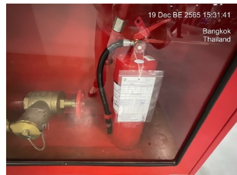
ภาพที่ 2.2-46 TAG ตรวจสอบถังดับเพลิง
