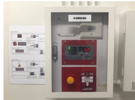
ภาพที่ 2.2-40 แผงควบคุม (FCP)
