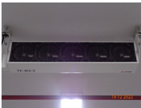
ภาพที่ 2.2-8 พัดลมระบายอากาศบริเวณชั้นจอดรถ
