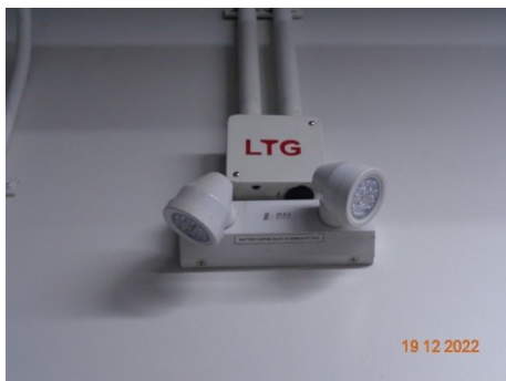
ภาพที่ 2.2-27 ระบบไฟฟ้าฉุกเฉิน
