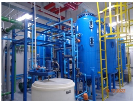
ภาพที่ 2.2-18 ระบบสูบน้ำในอาคาร/ถังสำรองน้ำในอาคาร
