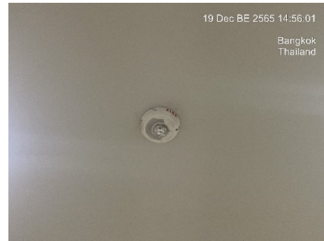
ภาพที่ 2.2-30 เครื่องตรวจจับความร้อน
