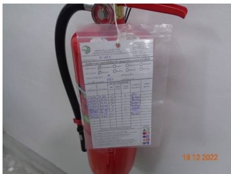
ภาพที่ 2.2-46 TAG ตรวจสอบถังดับเพลิง
