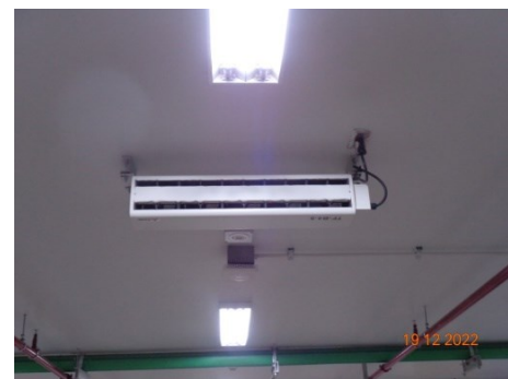
ภาพที่ 2.2-8 พัดลมระบายอากาศบริเวณชั้นจอดรถ
