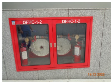
ภาพที่ 2.2-36 ตู้เก็บหัวฉีดน้ำดับเพลิง
