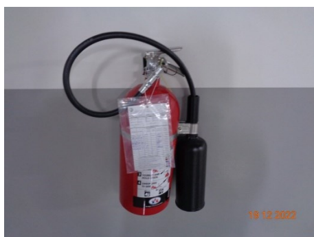
ภาพที่ 2.2-37 ถังดับเพลิงมือถือชนิด CO 2
