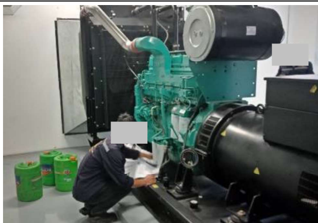
รูปที่ 2-22 การติดตั้งเครื่องกำเนิดไฟฟ้าสำรองของโครงการ
