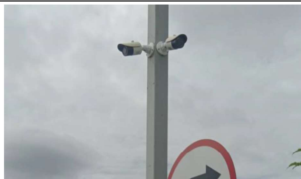
รูปที่ 2-19 การติดตั้งกล้องวงจรปิด (CCTV) บริเวณที่จอดรถ และบริเวณโดยรอบโครงการ
