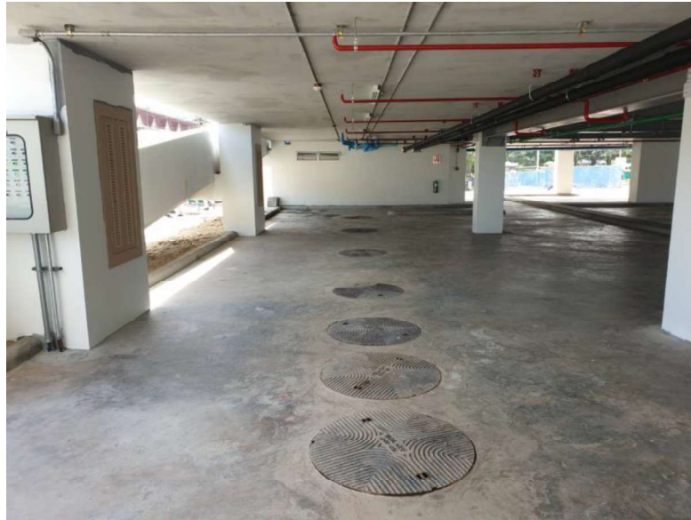
รูปที่ 2-9 การติดตั้งระบบบำบัดน้ำเสียของโครงการ
