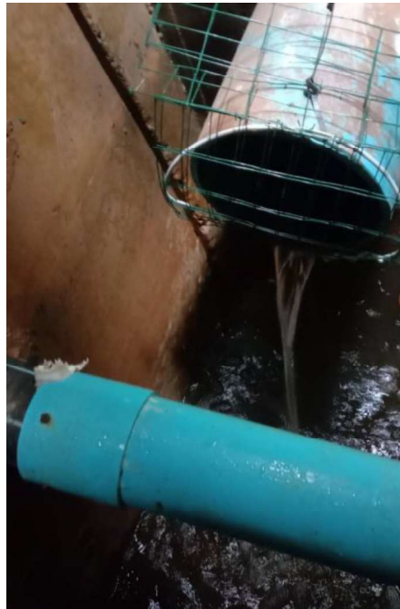
รูปที่ 2-34 ตะแกรงดักขยะในบ่อพักน้ำสุดท้าย
