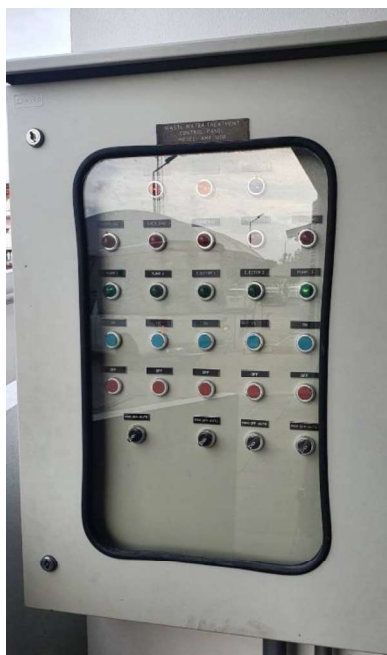
รูปที่ 2-12 การติดตั้งระบบควบคุม และมอเตอร์ไฟฟ้าสำหรับระบบบำบัดน้ำเสีย
