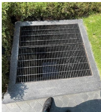
รูปที่ 2-23 ติดตั้งตะแกรงดักขยะ
