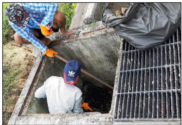
ภาพที่ 33 ขุดลอกท่อระบายน้ำรอบโครงการ
