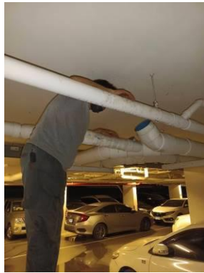
รูปที่ 2-33 ตรวจสอบและทำความสะอาดท่อระบายน้ำ
