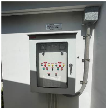
รูปที่ 2-12 ตู้ควบคุมระบบบำบัดน้ำเสีย
