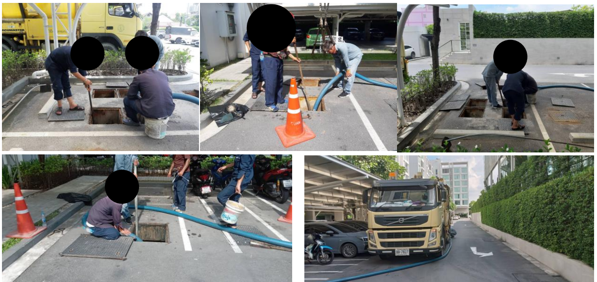
รูปที่ 2-41 สืบสิ่งปฏิกูลและดูดไขมัน เมื่อวันที่ 21 กันยายน 2565
