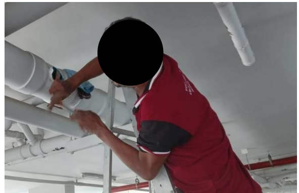
รูปที่ 2-33 ตรวจสอบและทำความสะอาดท่อระบายน้ำ
