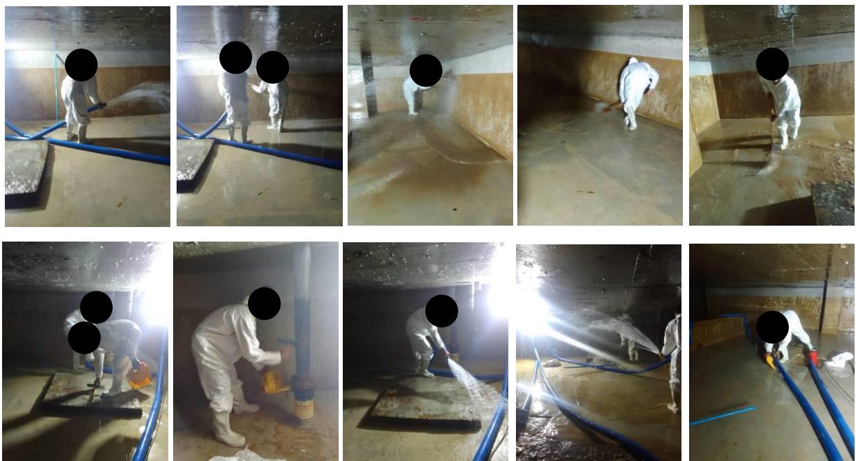
รูปที่ 2-32 ล้างทำความสะอาดถังเก็บน้ำ เมื่อวันที่ 23 พฤศจิกายน 2565
