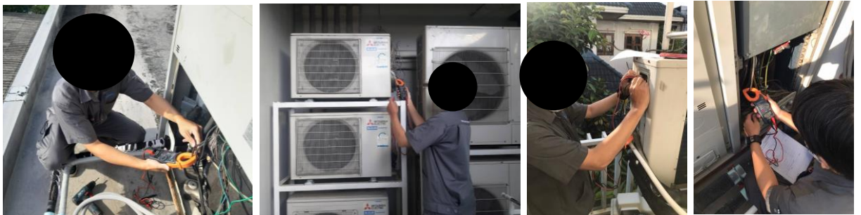
รูปที่ 2-40 เจ้าหน้าที่ PM ระบบปรับอากาศ
