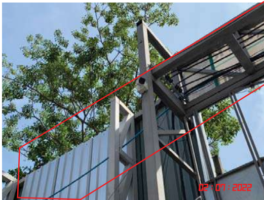
รูปที่ 2-11 การฉีดพรมน้ำในพื้นที่โครงการ
