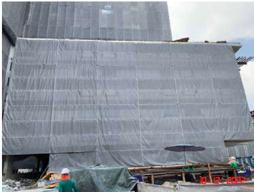
รูปที่ 2-7 การติดตั้ง Mesh Sheet คลุมตัวอาคาร
