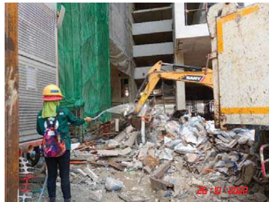
รูปที่ 2-11 การฉีดพรมน้ำในพื้นที่โครงการ
