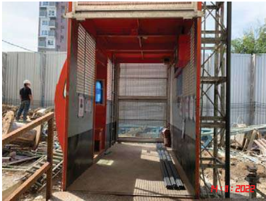
รูปที่ 2-28 การติดตั้งลิฟต์ขนส่งวัสดุก่อสร้าง
