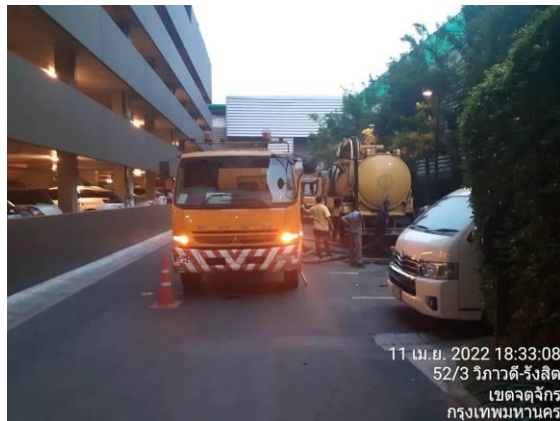
รูปที่ 2-45 ตรวจสอบและทำความสะอาดท่อระบายน้ำ
