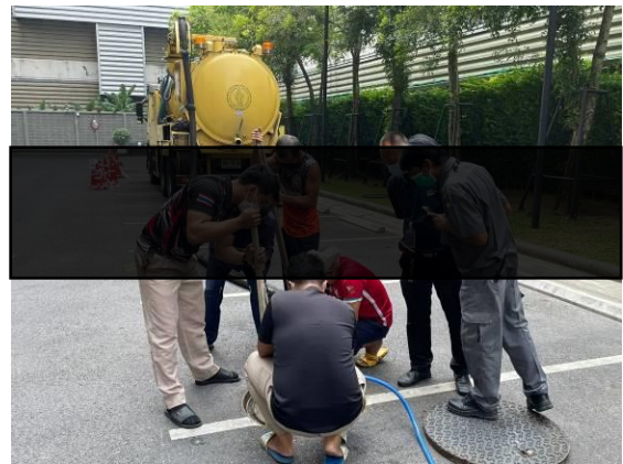
รูปที่ 2-45 ตรวจสอบและทำความสะอาดท่อระบายน้ำ
