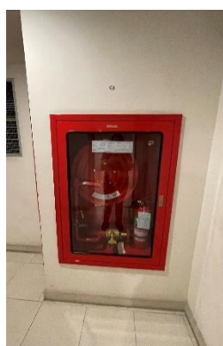
ตู้เก็บสายฉีดน้ำดับเพลิง พร้อมอุปกรณ์
