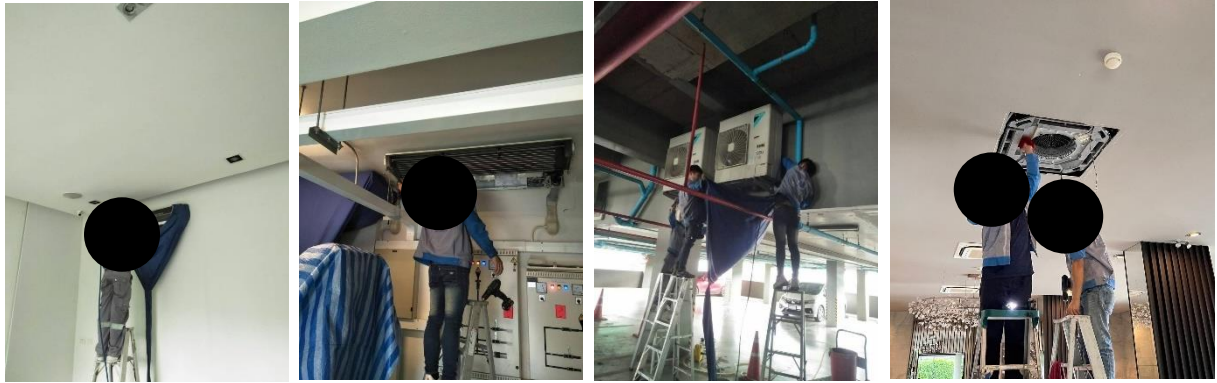
รูปที่ 2-37 ล้างแผ่นกรองและล้างแอร์ส่วนกลาง
