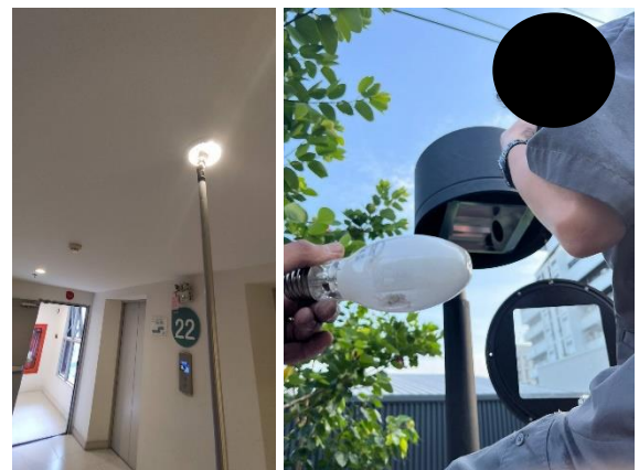
รูปที่ 2-24 เจ้าหน้าที่เปลี่ยนหลอดไฟพื้นที่ส่วนกลาง
