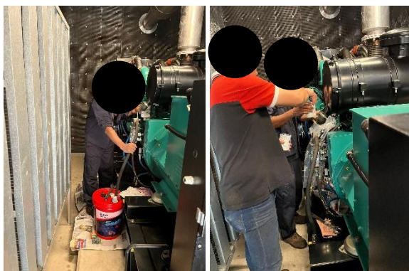
รูปที่ 2-29 เจ้าหน้าที่ตรวจสอบเครื่องกำเนิดไฟฟ้าสำรอง
