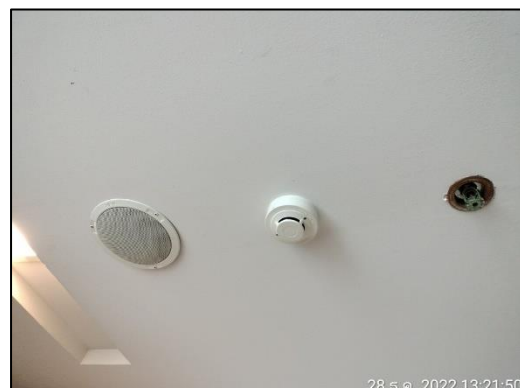
ภาพที่ 13 เครื่องตรวจจับความร้อน/เครื่องตรวจจับควัน
