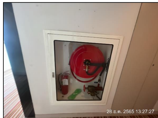
ภาพที่ 37 ตู้เก็บสายฉีดน้ำดับเพลิง
