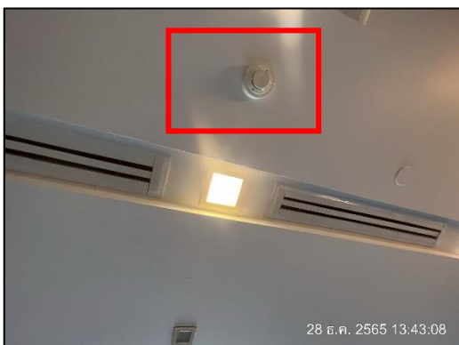
ภาพที่ 13 เครื่องตรวจจับความร้อน/เครื่องตรวจจับควัน
