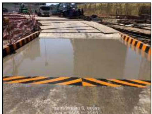
ภาพที่ 16 พื้นที่ล้างล้อรถบรรทุก
