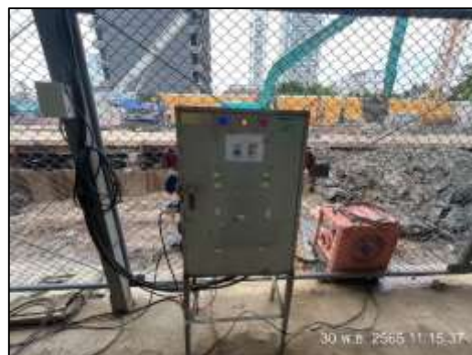
ภาพที่ 40 อุปกรณ์จ่ายไฟฟ้า
