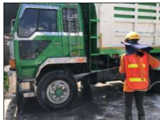
ภาพที่ 16 พื้นที่ล้างล้อรถบรรทุก
