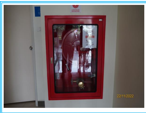
รูปที่ 3-46 ระบบท่อเย็น ตู้ดับเพลิง (FHC)
