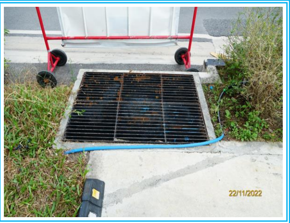
รูปที่ 3-37 บ่อดักขยะ ก่อนปล่อยสู่สาธารณะ
