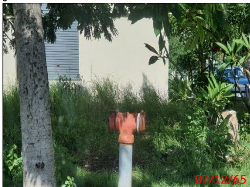
รูปที่ 2.2-3 หัวรับน้ำดับเพลิงภายในโครงการ
