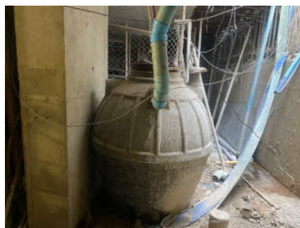
ภาพที่ 2.2-22 ห้องน้ำ และระบบบำบัดน้ำเสียสำเร็จรูปบริเวณพื้นที่โครงการ
