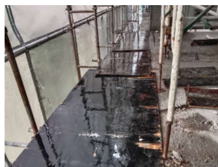
ภาพที่ 2.2-33 การป้องกันวัสดุตกหล่นจากอาคาร
