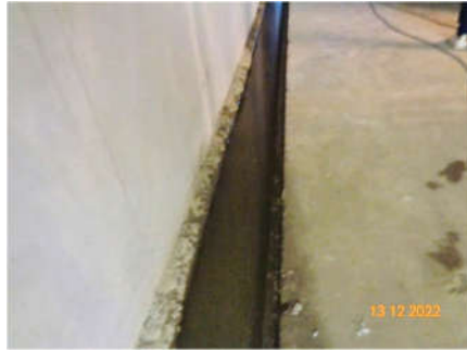
ภาพที่ 2.2-10 รังระบายน้ำ และบ่อบักน้ำภายในพื้นที่โครงการ
