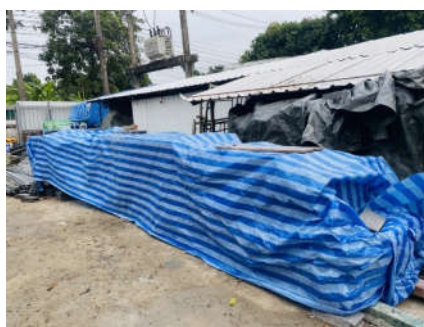
ภาพที่ 2.2-9 การปิดคลุมวัสดุก่อสร้าง
