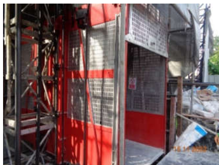
ภาพที่ 2.2.29 ลิฟต์โดยสารและขนส่งวัสดุชั่วคราว
