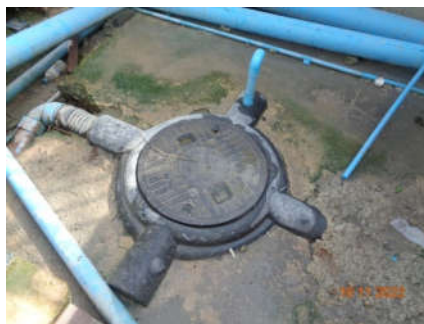
ภาพที่ 2.2-7 ห้องส้วมและระบบบำบัดน้ำเสีย
