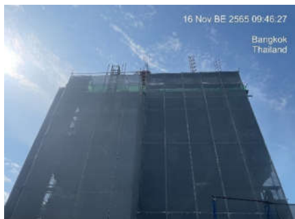
ภาพที่ 2.2-11 ผ้าใบก่อสร้าง (Mesh Sheet)
