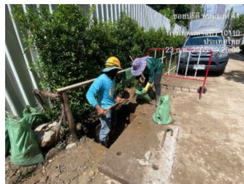
ภาพที่ 2.2-42 การขุดลอกท่อระบายน้ำสาธารณะ
