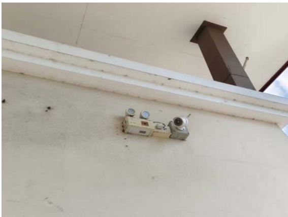
รูปที่ 3-21 ระบบกล้องโทรทัศน์วงจรปิด (CCTV)
