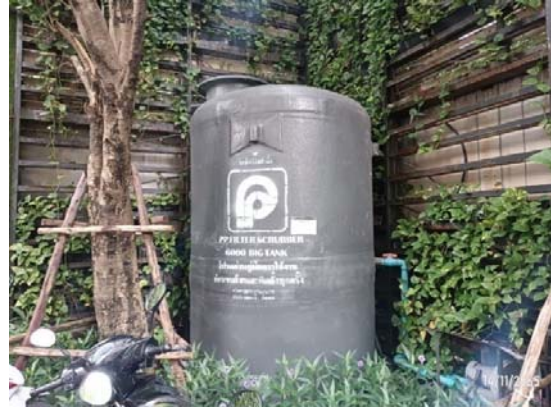
รูปที่ 2-13 ระบบบำบัดละอองน้ำเสีย
