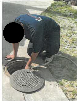
รูปที่ 2-5 แสดงเจ้าหน้าที่เทคนิคดูแลระบบบำบัดน้ำเสีย พร้อมทั้งนำไขมันไปกำจัด และสูบตะกอนส่วนเกินออกจากระบบบำบัดน้ำเสียโครงการ
