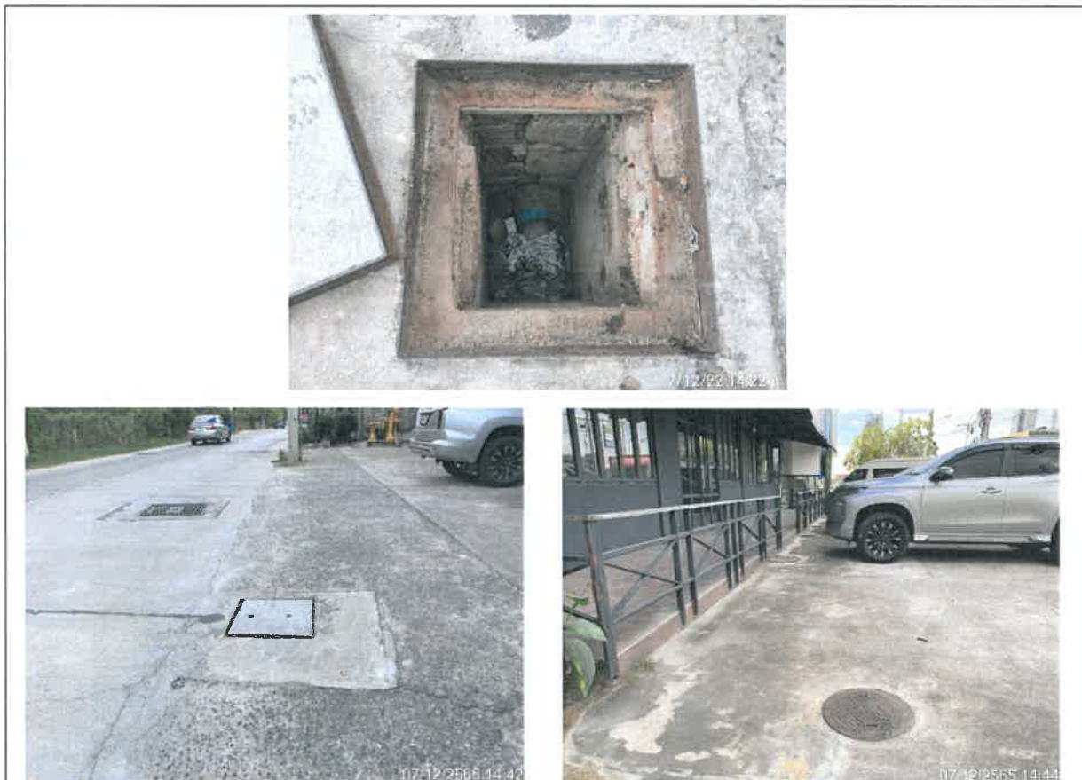
รูปที่ 2-4 แสดงการติดตั้งระบบบำบัดน้ำเสียชนิดเกราะ-กรองเติมอากาศ (Septic-Aerobic Filter Tank) บริเวณด้านข้างอาคารโครงการ
