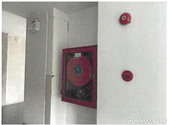
รูปที่ 2-34 แสดงตู้เก็บสายฉีดน้ำดับเพลิง (Fire Hose Cabinet) และถังดับเพลิงแบบมือถือ
