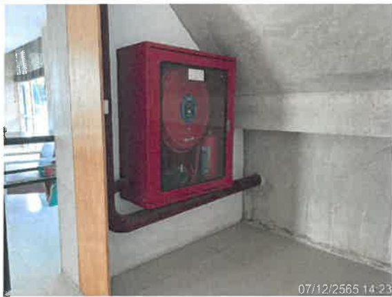
รูปที่ 2-34 แสดงตู้เก็บสายฉีดน้ำดับเพลิง (Fire Hose Cabinet) และถังดับเพลิงแบบมือถือ
