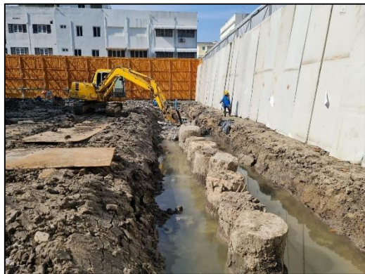
ภาพที่ 60 ระบบค้ำยันและ Pile Wall บริเวณพื้นที่ก่อสร้างอาคารจอดรถ
