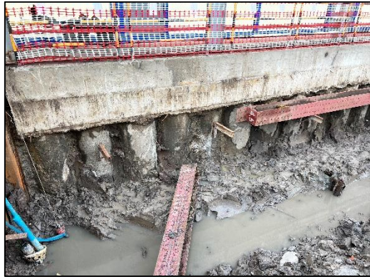
ภาพที่ 62 Pile Wall บริเวณพื้นที่ก่อสร้างอาคารชุดพักอาศัย
