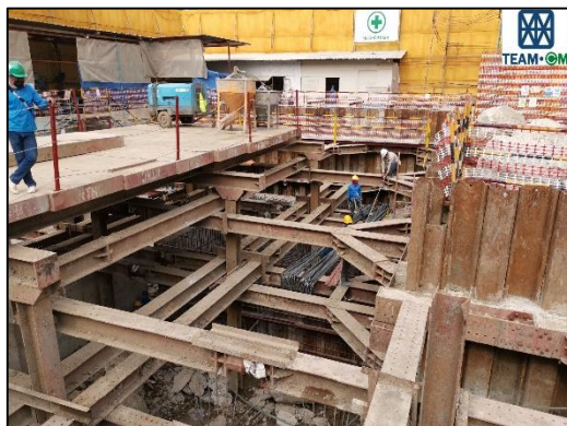
ภาพที่ 61 ระบบค้ำยันและ Steel Sheet Pile บริเวณพื้นที่ก่อสร้างอาคารชุดพักอาศัย
