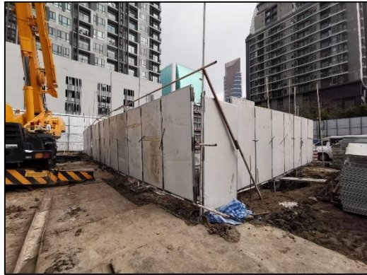
ภาพที่ 59 กำแพงกันเสียงล้อมรอบแหล่งกำเนิดเสียง
