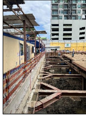
ภาพที่ 62 Pile Wall บริเวณพื้นที่ก่อสร้างอาคารชุดพักอาศัย
