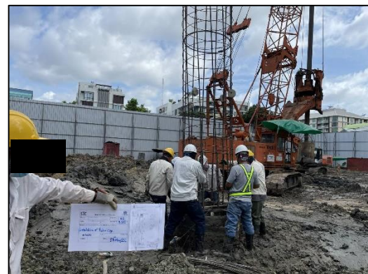
ภาพที่ 20 เสาค้ำเข็มเจาะ
