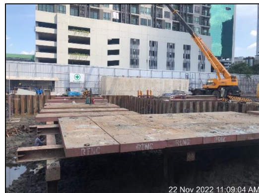
ภาพที่ 61 ระบบค้ำยันและ Steel Sheet Pile บริเวณพื้นที่ก่อสร้างอาคารชุดพักอาศัย
