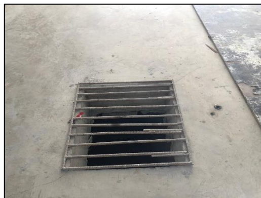
ภาพที่ 35 บ่อพักก่อนระบายออกสู่ท่อระบายน้ำสาธารณะ
