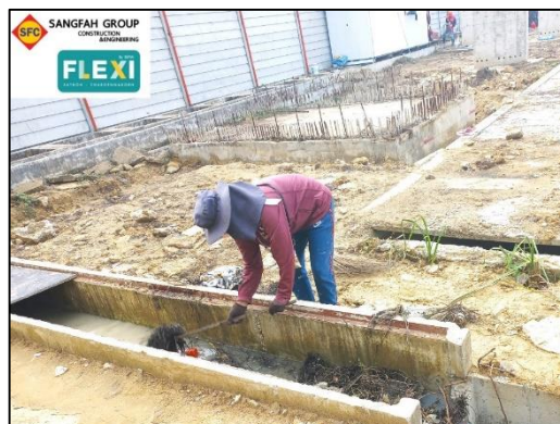
ภาพที่ 22 ขุดลอกตะกอนดินในรางระบายน้ำชั่วคราว
