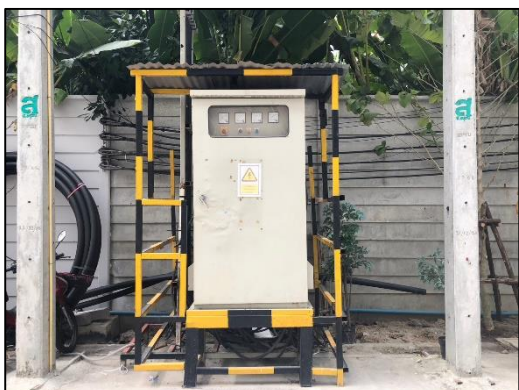
ภาพที่ 21 ติดตั้งอุปกรณ์ตัดกระแสไฟฟ้า
