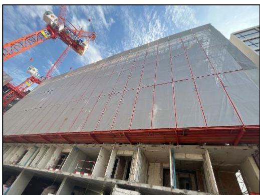
ภาพที่ 5 ติดตั้งผ้าใบ Mesh Sheet
