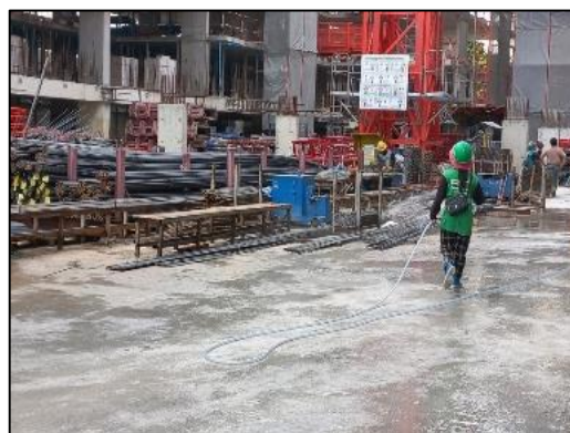
ภาพที่ 6 ฉีดพรมน้ำบริเวณพื้นที่ก่อสร้าง
