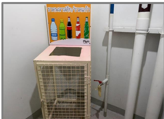
รูปที่ 15 ท่อรวบรวมน้ำเสียจากห้องพักมูลฝอยรวม
