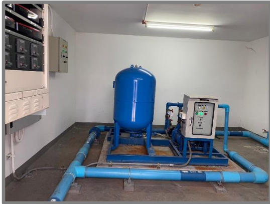
รูปที่ 9 เครื่องสูบน้ำดูดฟ้าและใต้ดิน
