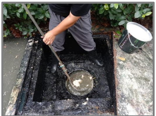
รูปที่ 39 การลอกท่อระบายน้ำและดักไขมัน
