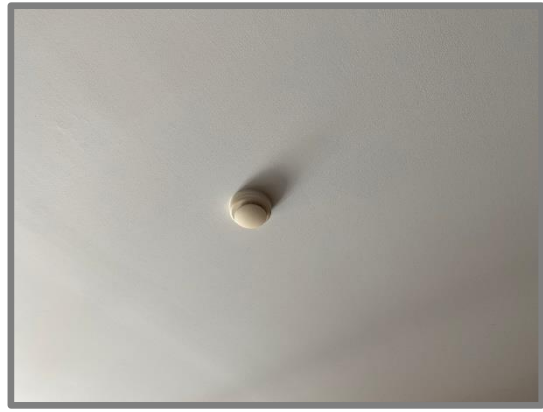
รูปที่ 25 ระบบเตือนอัคคีภัยเครื่องจับควัน
