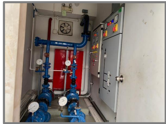
รูปที่ 9 เครื่องสูบน้ำดูดฟ้าและใต้ดิน
