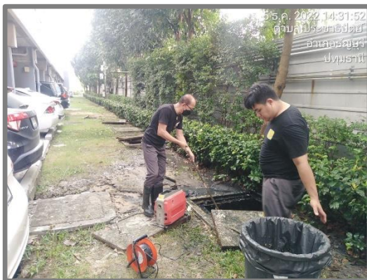
รูปที่ 39 การลอกท่อระบายน้ำและดักไขมัน
