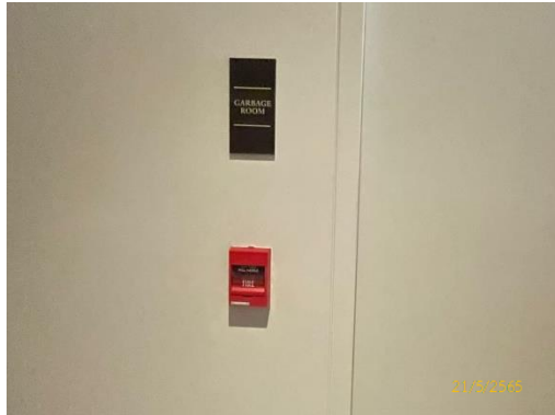
รูปที่ 2-20 อุปกรณ์แจ้งเหตุด้วยมือ
