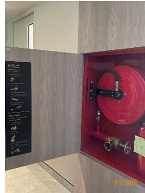
รูปที่ 2-21 ตู้เก็บสายฉีดน้ำดับเพลิง
