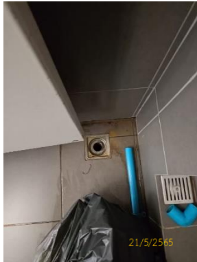
รูปที่ 2-14 ท่อระบายน้ำจากห้องพักขยะ
