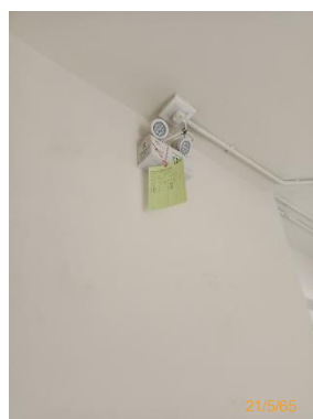
รูปที่ 2-25 ไฟส่องสว่างฉุกเฉิน
