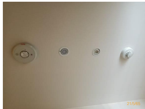
รูปที่ 2.17 เครื่องตรวจจับควัน
