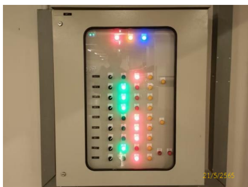
รูปที่ 2-6 ตู้ควบคุมระบบบำบัดน้ำเสีย
