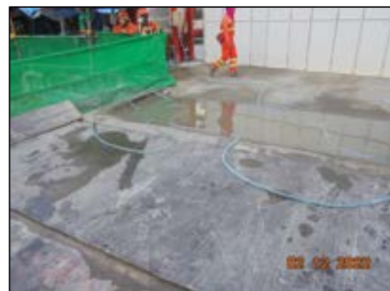
รูปที่ 10 พื้นที่ทำความสะอาดล้อรถบรรทุก และเจ้าหน้าที่ใช้น้ำฉีดล้างล้อก่อนออกจากโครงการ
