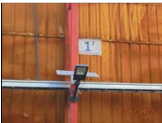
รูปที่ 30 ไฟส่องสว่าง และรางเก็บสายไฟบริเวณรั้วโครงการ โดยไม่ใช่ชุดสายพ่วงต่อพ่วงกันหลายชั้น
