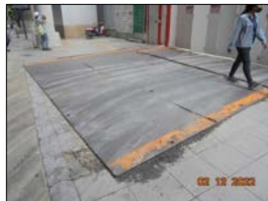
รูปที่ 18 ปูแผ่นเหล็ก (Platform) เพื่อลดความสั่นสะเทือนจากการเดินรถภายในพื้นที่โครงการ
