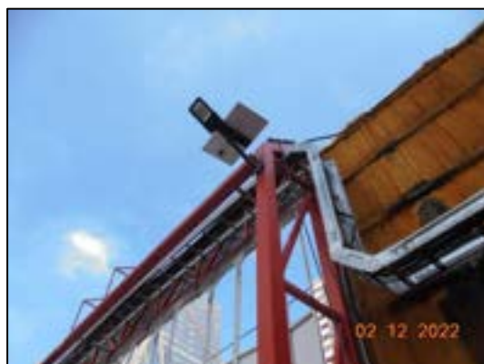
รูปที่ 30 ไฟส่องสว่าง และรางเก็บสายไฟบริเวณรั้วโครงการ โดยไม่ใช่ชุดสายพ่วงต่อพ่วงกันหลายชั้น
