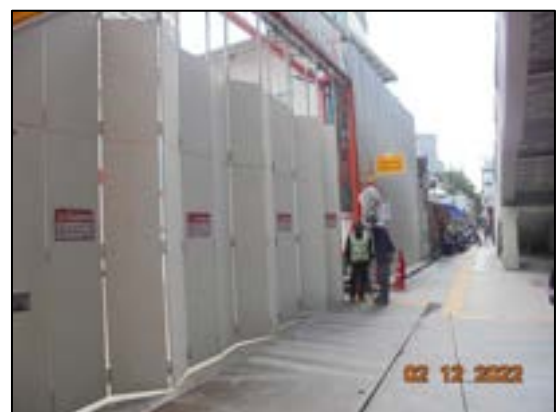
รูปที่ 14 ประตูทางเข้า - ออกพื้นที่ก่อสร้าง เป็นประตูเลื่อน และปิดทึบตลอดเวลา
