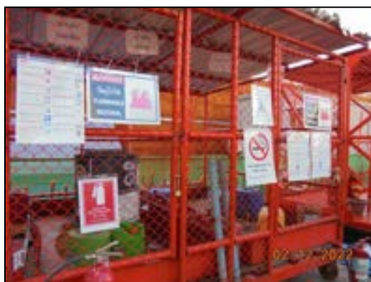
รูปที่ 28 พื้นที่วางวัตถุกันไฟ หรือสารเคมีให้เป็นสัดส่วนพร้อมติดป้ายเตือนอย่างชัดเจน
