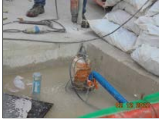
รูปที่ 23 วางระบายน้ำ บริเวณโดยรอบของพื้นที่โครงการ เพื่อรวบรวมน้ำเข้าสู่บ่อพักน้ำ
