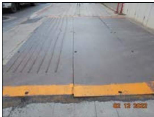
รูปที่ 18 ปูแผ่นเหล็ก (Platform) เพื่อลดความสั่นสะเทือนจากการเดินรถภายในพื้นที่โครงการ
