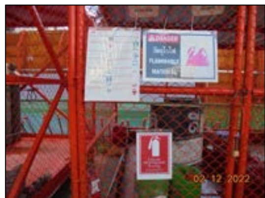
รูปที่ 28 พื้นที่วางวัตถุกันไฟ หรือสารเคมีให้เป็นสัดส่วนพร้อมติดป้ายเตือนอย่างชัดเจน
