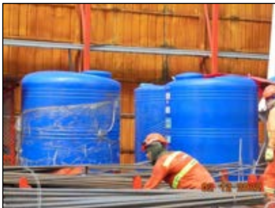
รูปที่ 21 ระบบบำบัดน้ำเสียชนิดเติมอากาศ จำนวน 1 ชุด
