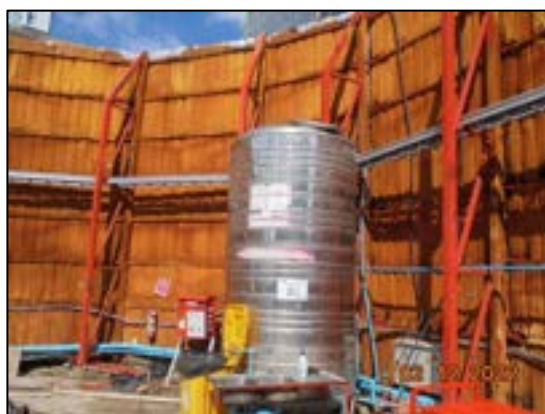
รูปที่ 22 ถังสำรองน้ำใช้อย่างน้อย 25 ลูกบาศก์เมตร/วัน (สำรองน้ำได้อย่างน้อย 1 วัน)
