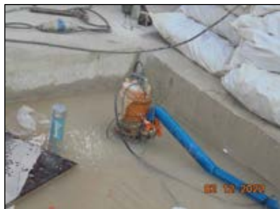
รูปที่ 24 เครื่องสูบน้ำสูบรวมระบายน้ำจากก่อสร้างขึ้นได้ดินออกสู่รางระบายน้ำที่อยู่โดยรอบพื้นที่โครงการ
