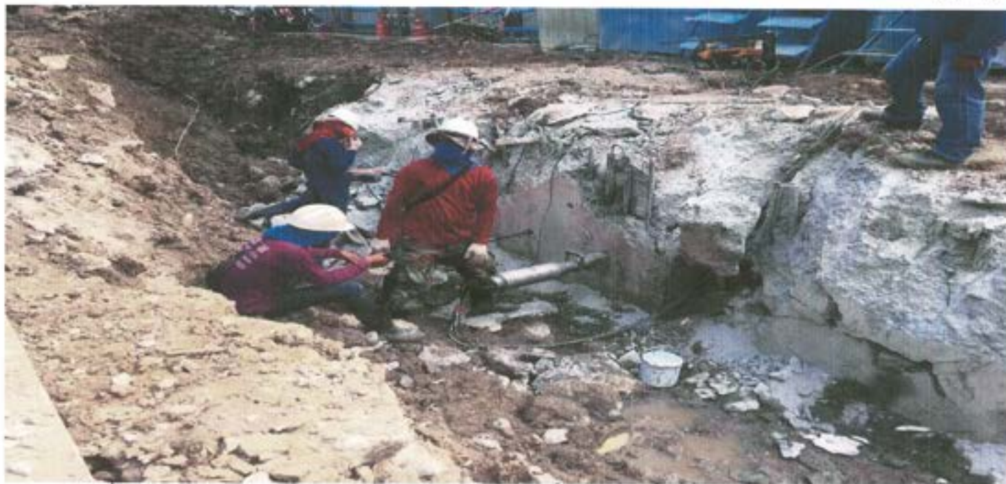
5 ใช้เครื่อง Hydraulic rock concrete splitters เบ่งคอนกรีตตามรูสว่านที่ทำการเจาะ เพื่อให้คอนกรีตแยกตามลำดับ
