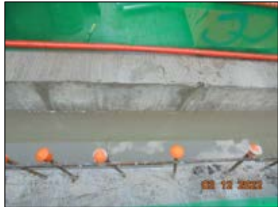
รูปที่ 23 วางระบายน้ำ บริเวณโดยรอบของพื้นที่โครงการ เพื่อรวบรวมน้ำเข้าสู่บ่อพักน้ำ
