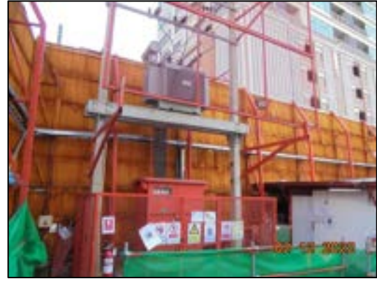
รูปที่ 31 หม้อแปลงไฟฟ้าในพื้นที่ก่อสร้าง เพื่อควบคุมปริมาณการใช้ไฟฟ้า
