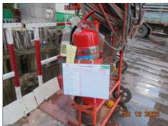
รูปที่ 26 ถังดับเพลิงเคมีอย่างเพียงพอ ภายในพื้นที่โครงการ และติดป้ายแนะนำการใช้งาน
