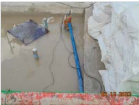
รูปที่ 23 วางระบายน้ำ บริเวณโดยรอบของพื้นที่โครงการ เพื่อรวบรวมน้ำเข้าสู่บ่อพักน้ำ
