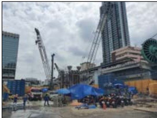
รูปที่ 15 ก่อสร้างฐานรากโดยใช้เสาเข็มเจาะ เพื่อป้องกันผลกระทบต่อผู้อยู่ใกล้เคียง
