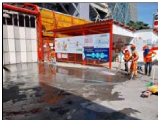
รูปที่ 6 (ต่อ) พนักงานคอยกวาดเศษดิน/ทราย บริเวณปากทางเข้า-ออก และบริเวณโดยรอบพื้นที่ก่อสร้าง พร้อมทั้งฉีดพรมน้ำบริเวณพื้นที่ก่อสร้างและบริเวณที่ก่อให้เกิดฝุ่นละออง
