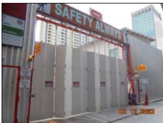
รูปที่ 14 ประตูทางเข้า - ออกพื้นที่ก่อสร้าง เป็นประตูเลื่อน และปิดทึบตลอดเวลา
