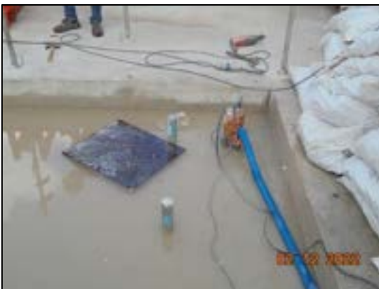
รูปที่ 24 เครื่องสูบน้ำสูบรวมระบายน้ำจากก่อสร้างขึ้นได้ดินออกสู่รางระบายน้ำที่อยู่โดยรอบพื้นที่โครงการ
