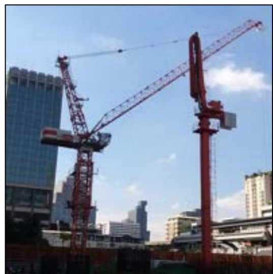
รูปที่ 43 เครน และทาวเวอร์เครนที่สามารถพับแขนได้ ติดตั้งเฉพาะภายในพื้นที่โครงการเท่านั้น
