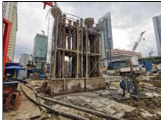
รูปที่ 15 ก่อสร้างฐานรากโดยใช้เสาเข็มเจาะ เพื่อป้องกันผลกระทบต่อผู้อยู่ใกล้เคียง
