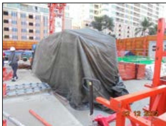
รูปที่ 5 พื้นที่สำหรับการกอง/เก็บวัสดุที่มีฝุ่นหรือเศษวัสดุที่เหลือใช้
