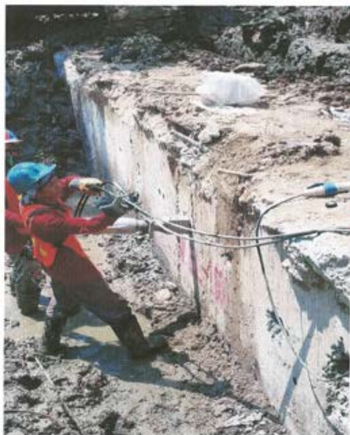
5 ใช้เครื่อง Hydraulic rock concrete splitters เบ่งคอนกรีตตามรูสว่านที่ทำการเจาะ เพื่อให้คอนกรีตแยกตามลำดับ
