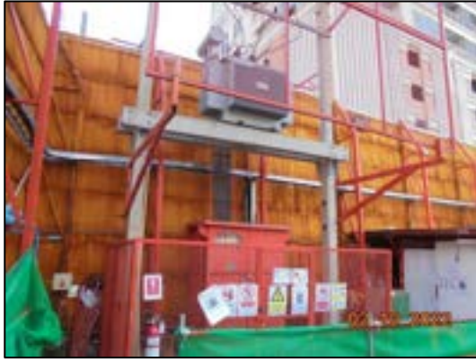
รูปที่ 31 หม้อแปลงไฟฟ้าในพื้นที่ก่อสร้าง เพื่อควบคุมปริมาณการใช้ไฟฟ้า
