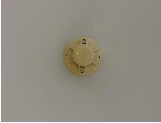
รูปที่ 32 เครื่องตรวจจับควัน (Smoke Detector)
