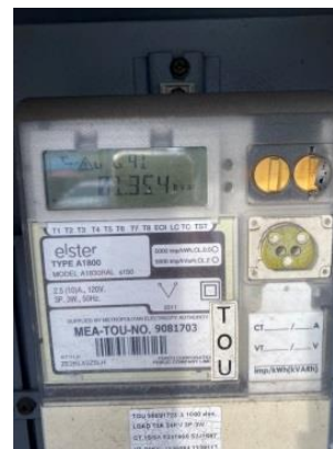
รูปที่ 6 ระบบมิเตอร์ไฟฟ้าสำหรับระบบบำบัดน้ำเสีย ของโครงการโดยเฉพาะแยกจากระบบไฟฟ้าอื่นๆ
