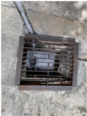
รูปที่ 10 ท่อระบายน้ำรองรับน้ำหลากที่ตกลงภายใน พื้นที่โครงการ
