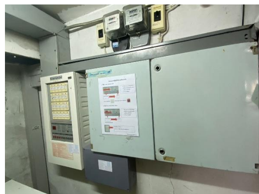
รูปที่ 31 แผงควบคุม (Fire Alarm Control Panel : FCP)
