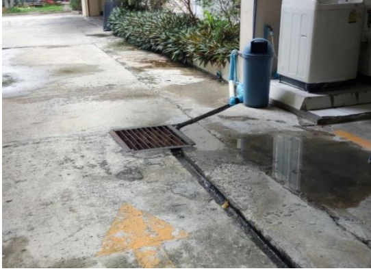
รูปที่ 46 ตะแกรงครอบคลุมรูท่อระบายน้ำทั้งภายใน และภายนอกอาคาร
