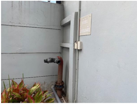
รูปที่ 26 หัวรับน้ำดับเพลิง (Siamese Connection)
