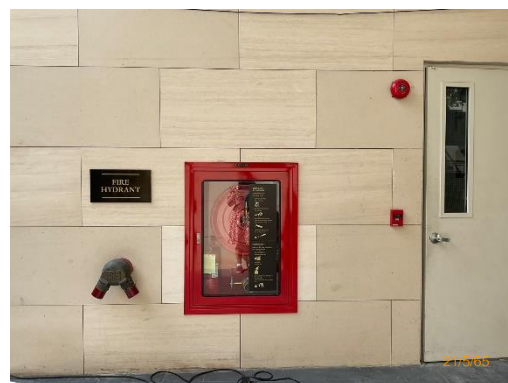
รูปที่ 2-19 หัวรับน้ำดับเพลิง อาคาร B
