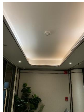
รูปที่ 2.17 เครื่องตรวจจับควัน
