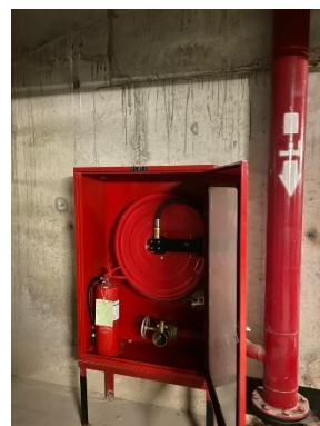
รูปที่ 2-30 ระบบดับเพลิงภายในที่จอดรถอัตโนมัติ
