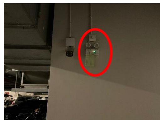
รูปที่ 2-25 ไฟส่องสว่างฉุกเฉิน
