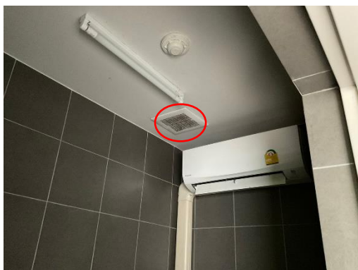
รูปที่ 2-16 ท่อระบายอากาศในห้องพักขยะ
