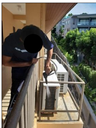
รูปที่ 3-31 เจ้าหน้าที่ทำความสะอาดระบบปรับอากาศ
