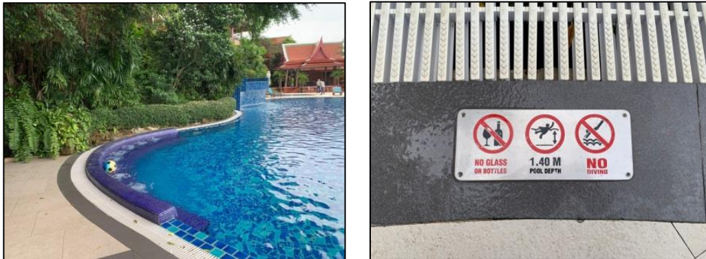
รูปที่ 3-22 รางระบายน้ำล้น/ป้ายบอกระดับความลึกสระว่ายน้ำ
