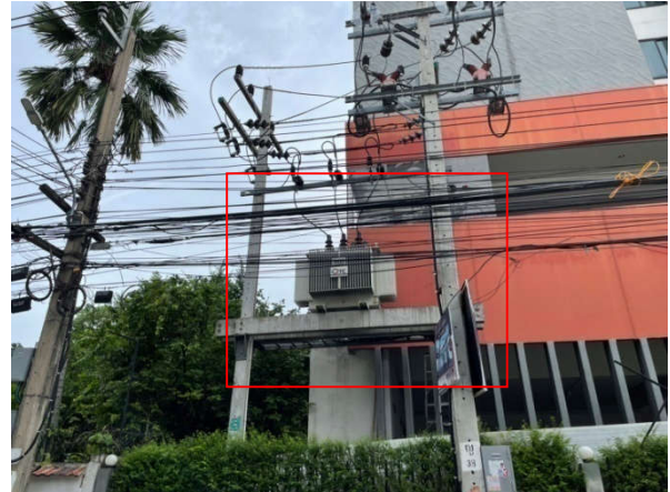
รูปที่ 2-23 หม้อแปลงไฟฟ้าแรงสูงจากการไฟฟ้านครหลวง
