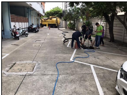
ภาพที่ 2-3 สำนักงานเขตธนบุรีเข้ามาสูบน้ำถ่ายตะกอน
