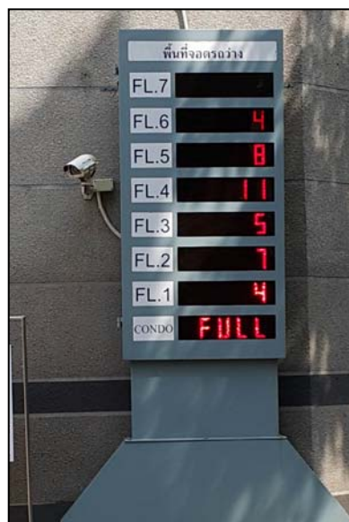
ภาพที่ 2-10 ระบบการตรวจนับช่องจอดรถในส่วนของ Plaza
