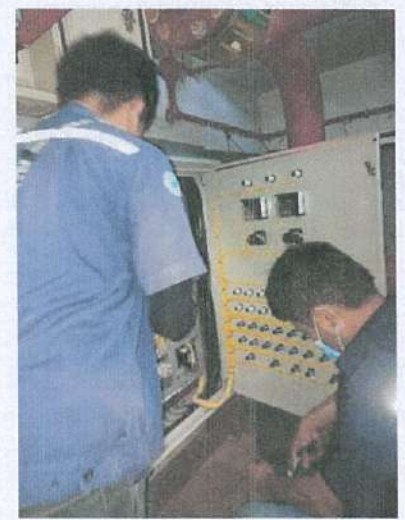
การตรวจเช็คระบบไฟฟ้า ภายในตู้ควบคุม
