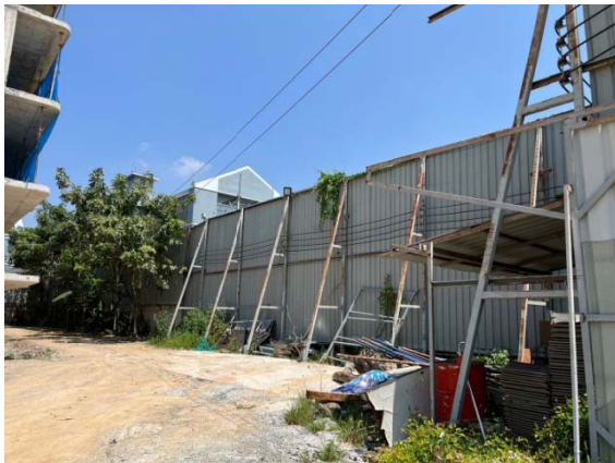
รูปที่ 2-1 แนวเขตที่ดินรั้ว Metal Sheet ความสูง 6 เมตร
