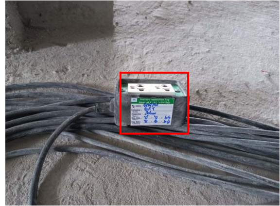
รูปที่ 2-15 การตรวจสอบเครื่องจักรอุปกรณ์
