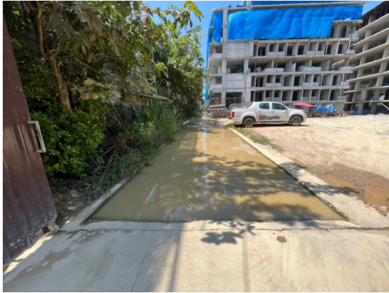
รูปที่ 2-6 พื้นที่สำหรับล้างล้อรถ และการล้างทำความสะอาดล้อรถ
