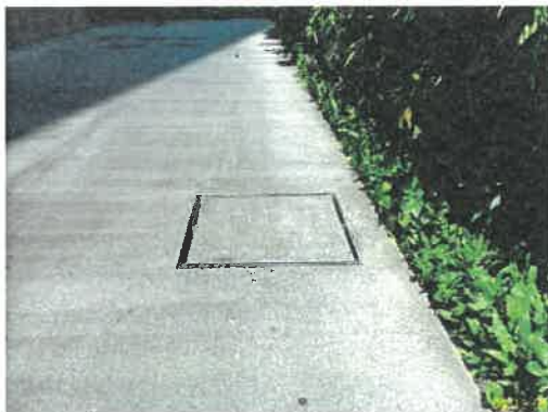
ระบายน้ำฝนรอบโครงการ ท่อระบายน้ำภายนอกอาคาร ภาพที่ 1.3.6-1 (ต่อ) การระบายน้ำของโครงการ
