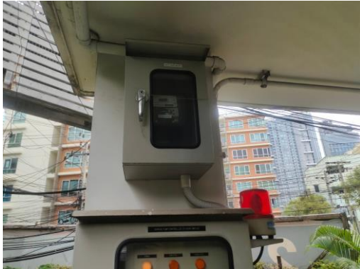
รูปที่ 31 ตู้ควบคุมระบบบำบัดน้ำเสีย/มิเตอร์น้ำเสีย
