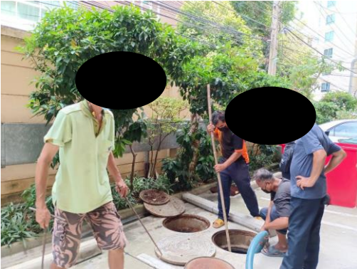
รูปที่ 7 สุ่มตะกอนออกจากระบบบำบัดน้ำเสีย
