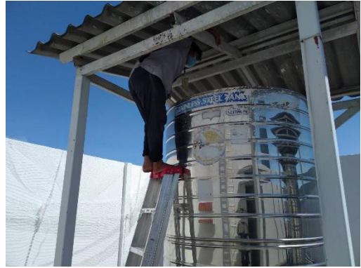
รูปที่ 15 การทำความสะอาดและตรวจสอบสภาพถังน้ำ
