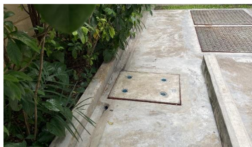
รูปที่ 16 บ่อหน่วงน้ำ ทางระบายน้ำ
