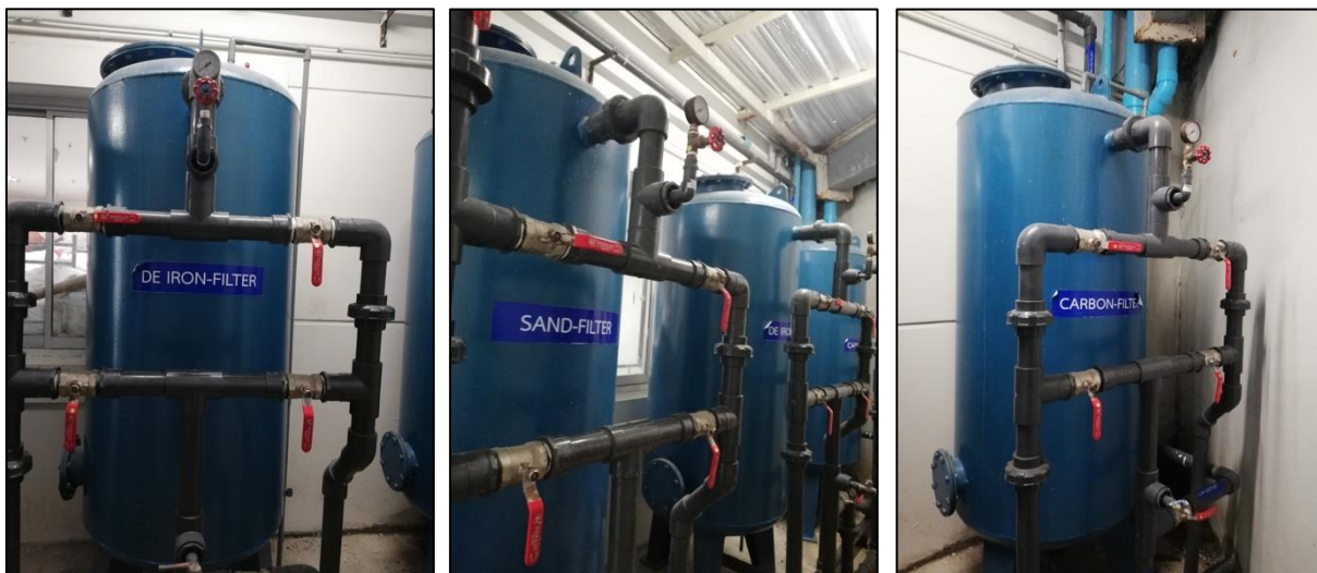
รูปที่ 2.5.1-3 รูปถ่ายระบบปรับปรุงคุณภาพน้ำของโครงการ
