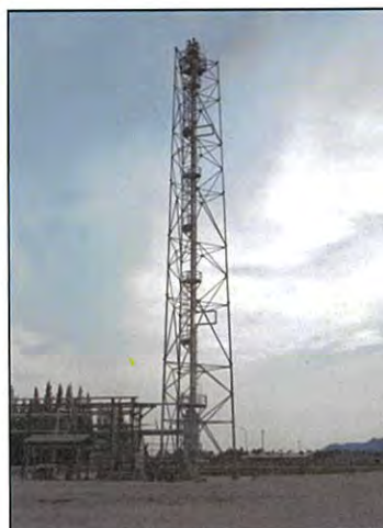
ภาพที่ 2-3 การติดตั้งอุปกรณ์ Flare (ปล่องเผาก๊าซหรือสารเคมี)
