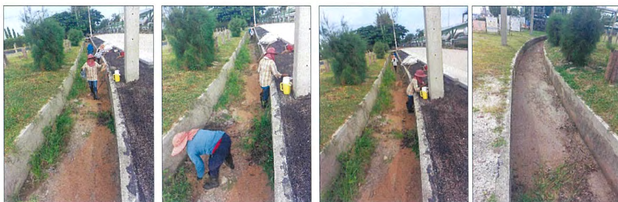
ภาพที่ 2-10 การทำความสะอาดและลอกตะกอนในรางระบายน้ำฝนในพื้นที่นิคมฯ
