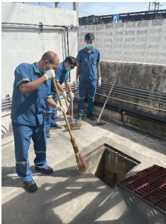
ภาพที่ 2.2-12 เก็บกวาดเศษขยะบริเวณตะแกรงดักขยะก่อนเข้าสู่บ่อท่วงน้ำฝนและก่อนระบายออกสู่ภายนอกโครงการ
