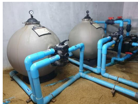
ภาพที่ 2.2-13 ระบบกรองของสระว่ายน้ำน้ำ
