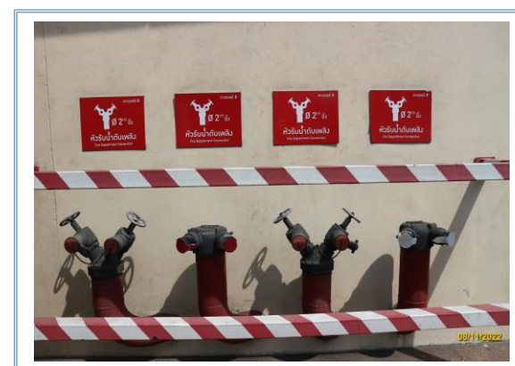
รูปที่ 3-60 ระบบหัวรับน้ำดับเพลิง
