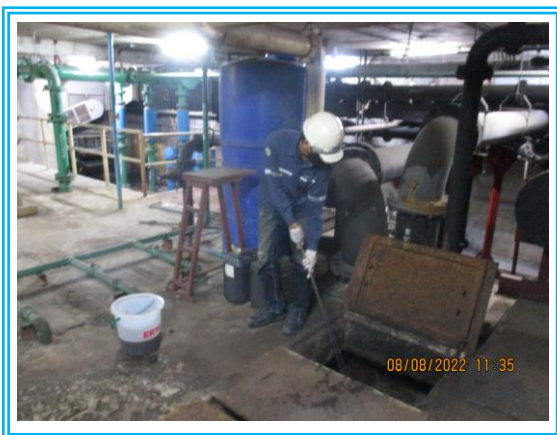
บ่อ Aerated Grit Chamber (ก่อนผ่านระบบฯ) เก็บตัวอย่างในวันที่ 8 สิงหาคม 2565
