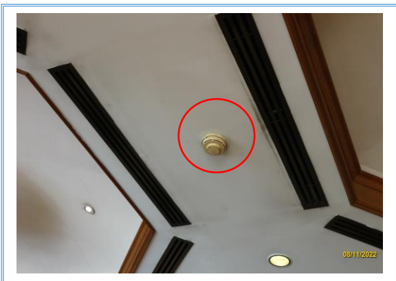
รูปที่ 3-54 เครื่องตรวจจับความร้อน
