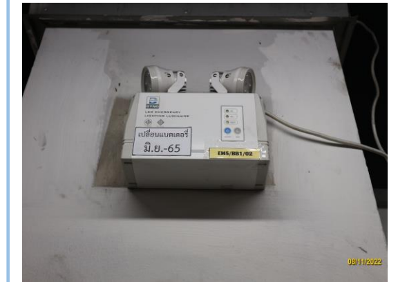
รูปที่ 3-55 ไฟส่องสว่างฉุกเฉิน
