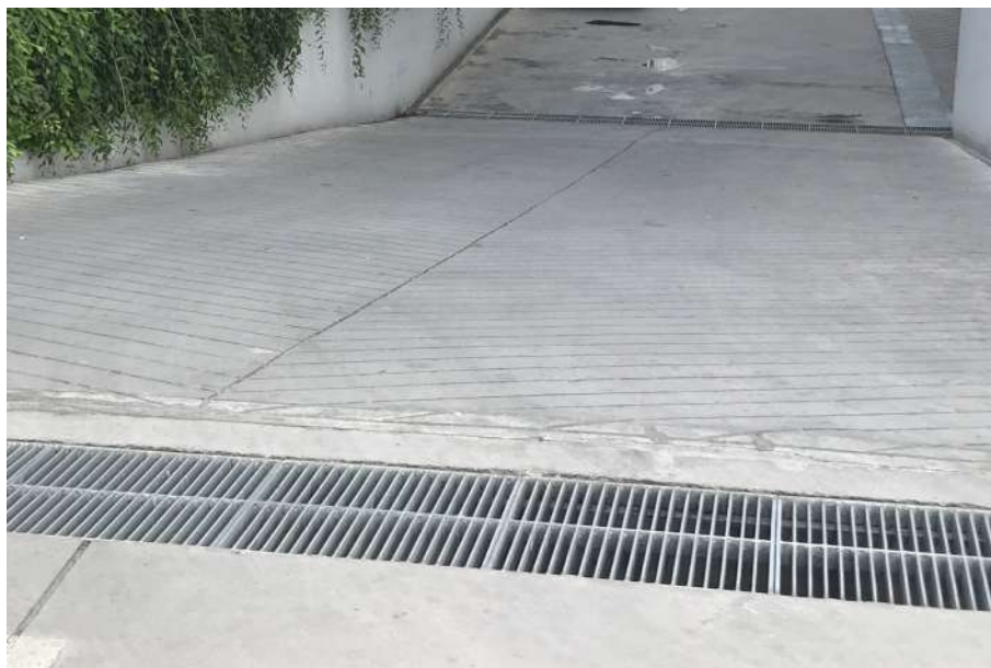
ภาพที่ 1-5 (ข) รางระบายน้ำฝนเข้าสู่บ่อหน่วงน้ำ
