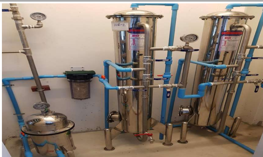
ภาพที่ 2-19 ระบบกรองน้ำดื่มประจำครัวและร้านอาหารของโครงการ
