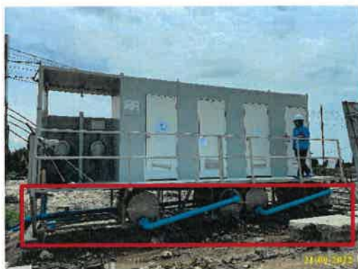
ภาพที่ 2.2-29 ถังบำบัดน้ำเสียสำเร็จรูป
