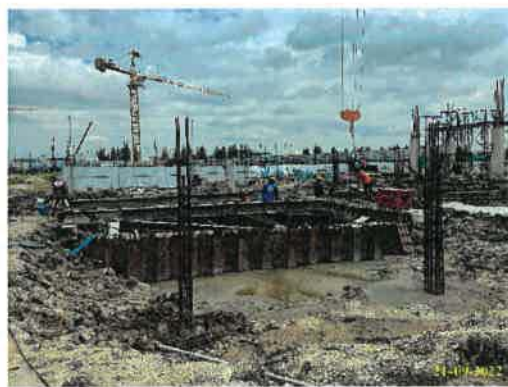
ภาพที่ 2.2-27 Sheet Pile ป้องกันการพังทลายของดิน
