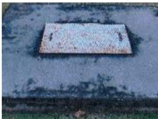
ภาพที่ 2.2-2 บ่อพักน้ำทิ้งหลังการบำบัดขนาด 1 วัน
