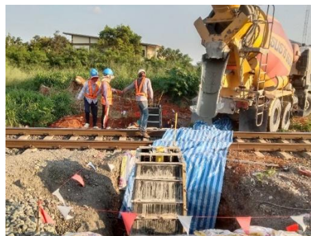
งานก่อสร้างฐานคอนกรีตสำหรับติดตั้งเสาสัญญาณ สถานีปากช่อง
