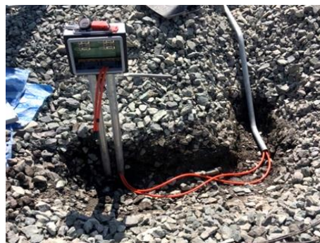
งานติดตั้ง Track Pipe ที่สถานีชุมม่วงถึงสถานีจันทัก
