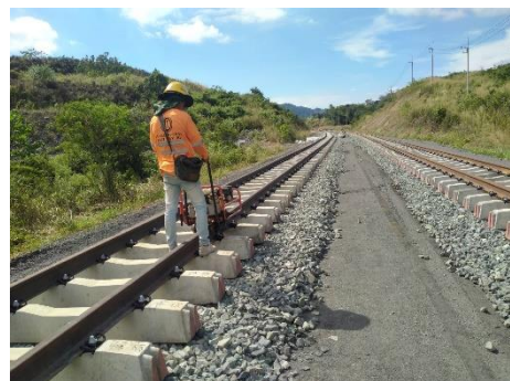
งาน Fastening for Monoblock Concrete
