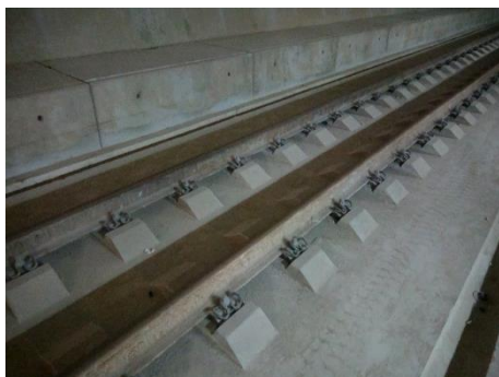
งาน Lay Plain Welded Track for 54E1
