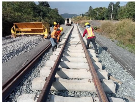
งาน Lay Plain Welded Track for 54E1
