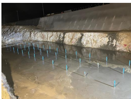
งาน Retention Pond – Lean concrete
