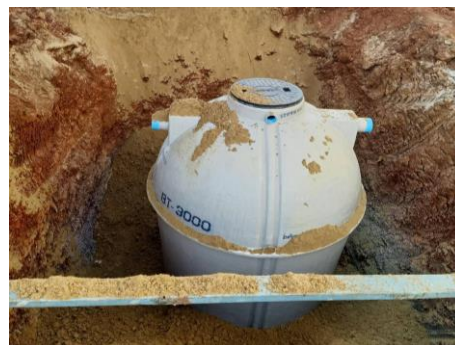
งานติดตั้งถังบำบัดอากาศระบบดับเพลิง
