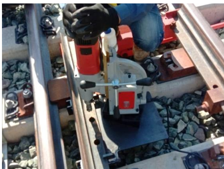
งานเจาะลิ้นประแจสำหรับติดตั้ง Point Machine สถานีชุมม่วง
