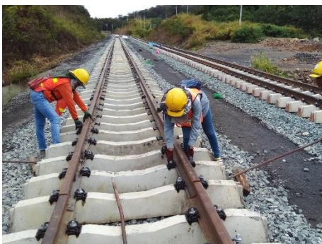
งาน Fastening for Monoblock Concrete
