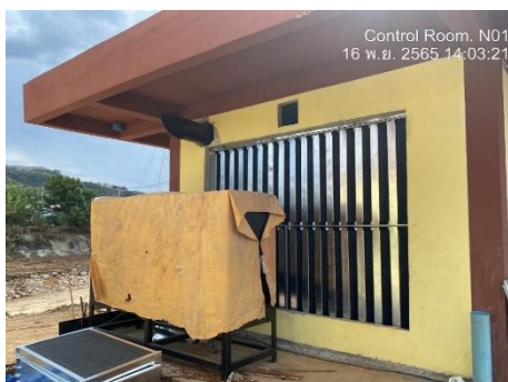
งานติดตั้งอุปกรณ์ Air Inlet และ Outlet สำหรับ ห้อง Generator
