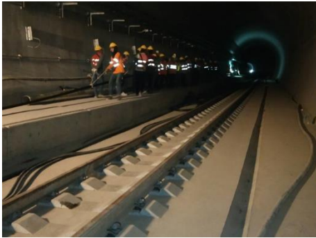
งานร้อยสายไฟแรงสูงใน Duct bank
