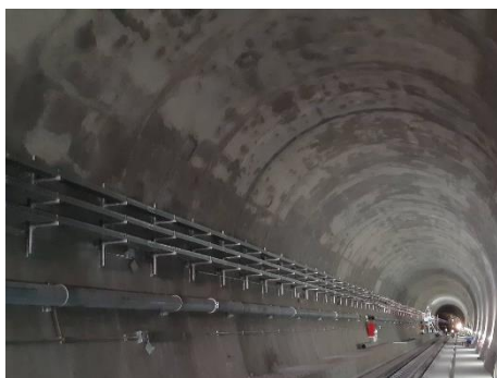
งานติดตั้งท่อและราง Cable Tray
