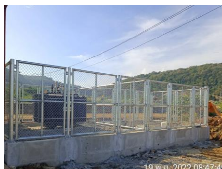
งานการติดตั้งรั้วตะแกรงเหล็ก Transformer Yard
