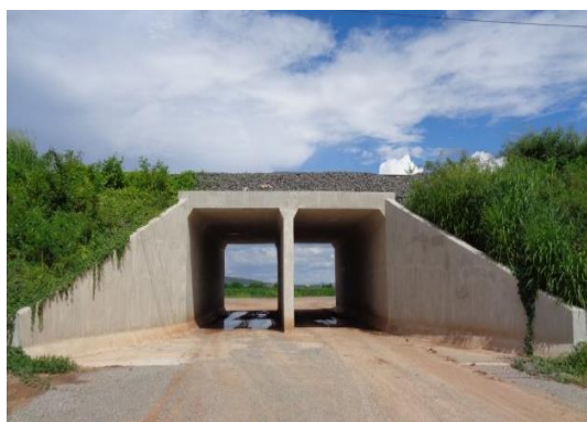
ท่อเหลี่ยมลอดใต้ทางรถไฟ (Box Culvert)
