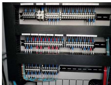
งาน Internal Wiring ภายในห้องรีเลย์ ที่สถานีปากช่อง
