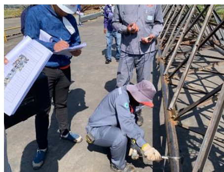
งานตรวจสอบเสา Digital Radio Tower 45 m
