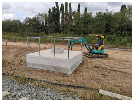
งานก่อสร้างฐานคอนกรีต สำหรับติดตั้งตู้ LOC สถานีปากช่อง
