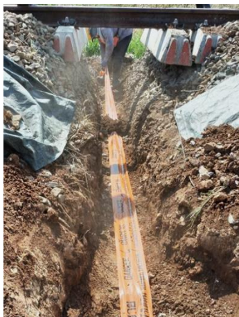
งานขุดวางท่อลอดใต้ราง (Undertrack Crossing) สถานีบ้านไผ่และสถานีปากช่อง
