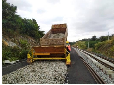
งาน Spread and Compact Bottom Ballast
