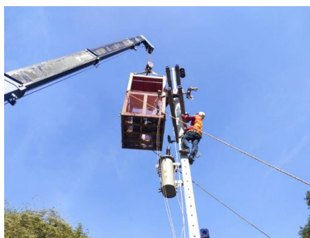
งานติดตั้งหม้อแปลงพร้อมอุปกรณ์จับยึดสาย (งานขยายเขตไฟฟ้าสำหรับห้องรีเลย์ของสถานีปางอโศก)
