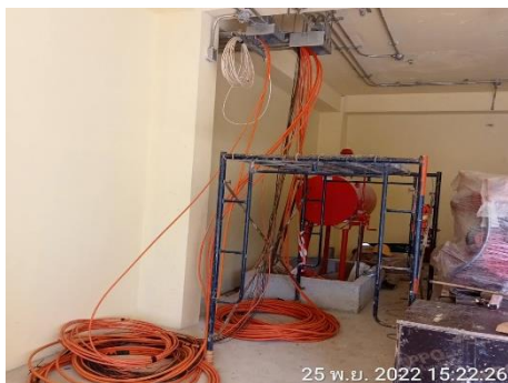
งานร้อยสายไฟอาคารระบบดับเพลิง
