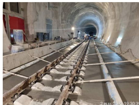
งาน Reinforced Concrete Track Bed
