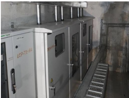
งานติดตั้งตู้ไฟ ในห้อง Equipment Room
