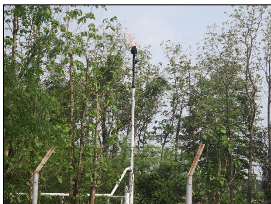
ภาพที่ 2.4-3 ระบบปล่อยเผาก๊าซในพื้นที่ฐานหลุมผลิตปรีอกระเทียม-บี (PKM-B)
