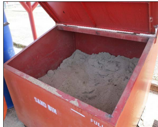
ภาพที่ 2.2-1 อุปกรณ์ป้องกันอัคคีภัยและอุปกรณ์ขจัดครบน้ำมันที่สถานีผลิตย่อยหนองตูม-เอ (NTM-A)
