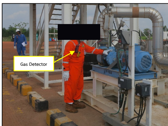
ภาพที่ 2.4-6 พนักงานสวมใส่อุปกรณ์ตรวจสอบการรั่วไหลของก๊าซแบบพกพา
