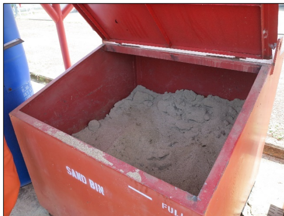
ภาพที่ 2.1-8 อุปกรณ์จัดครบน้ำมันที่สถานีผลิตย่อยหนองตุม-เอ (NTM-A)
