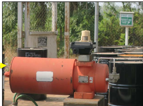
ภาพที่ 2.4-29 วาล์วหยุดการรั่วไหล (Shutdown valve)
