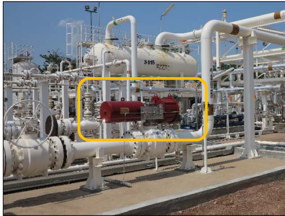
ภาพที่ 2.1-15 วาล์วหยุดการรั่วไหล (Shutdown valve)
