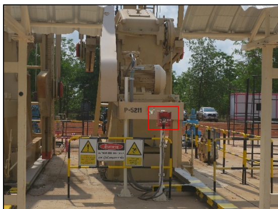
ภาพที่ 2.4-28 อุปกรณ์หยุดการทำงานฉุกเฉิน (OSD)
