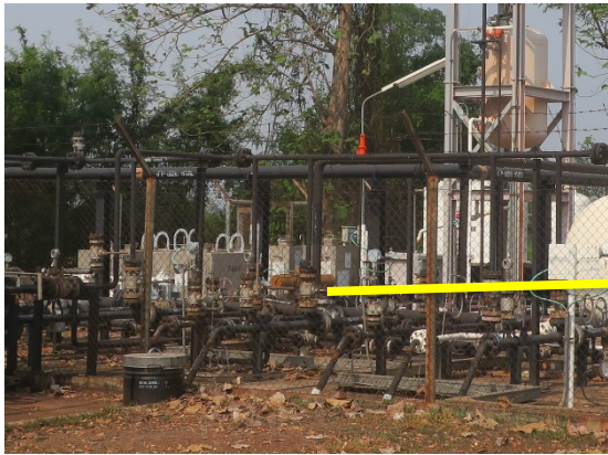
ภาพที่ 2.4-29 วาล์วหยุดการรั่วไหล (Shutdown valve)
