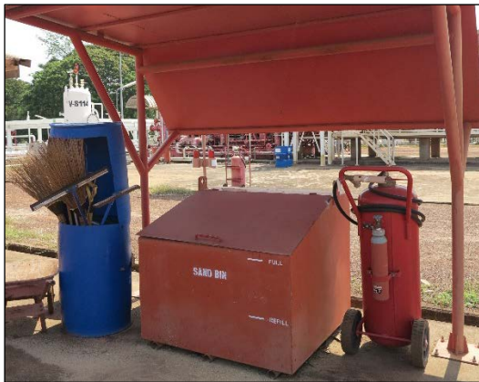
ภาพที่ 2.2-1 อุปกรณ์ป้องกันอัคคีภัยและอุปกรณ์ขจัดครบน้ำมันที่สถานีผลิตย่อยหนองตูม-เอ (NTM-A)
