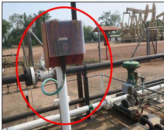
ภาพที่ 2.3-12 วาล์วหยุดการรั่วไหล (Shut Down Valve) ประจำพื้นที่ฐานหลุมผลิต
